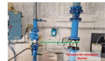
Injection de chlore liquide dans le réservoir principal
