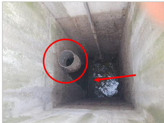
Trop Plein : en amont du dégrilleur du poste de relevage
