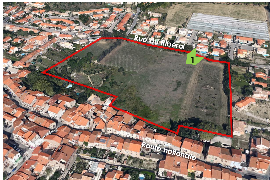
Vue aérienne du secteur d'étude
