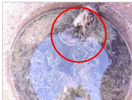
Chasse n°274 (Lotissement La Clave Verte) : présence d'un écoulement (débit de fuite \approx 0,1 \text{ m}^3/\text{h} )
