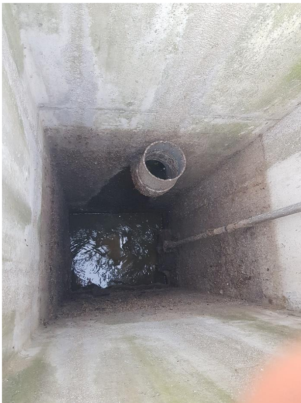
Déversoir amont dégrilleur
