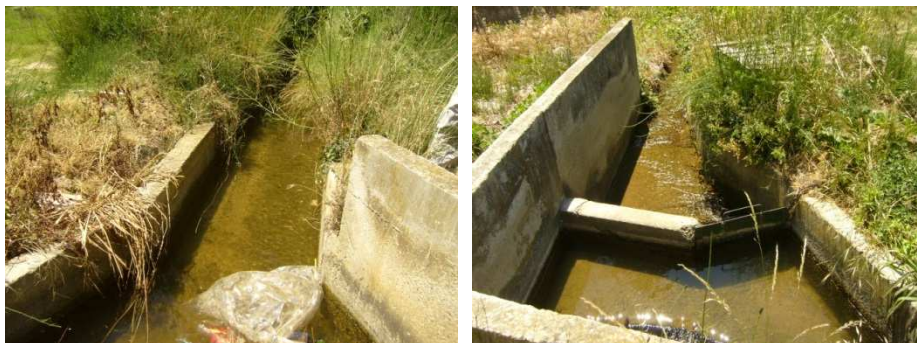
Fig. 7. Canal de Cabira en amont du ravin des Coumes de la Mort et ouvrage de rejet direct (ouverture de la pelle en période de crue)
