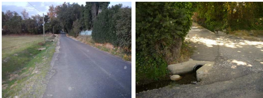
Fig. 14. A gauche : fossé le long de la rue d'Estagel A droite : rejet direct du fossé le long de la rue d'Estagel dans le canal de Figarolle
