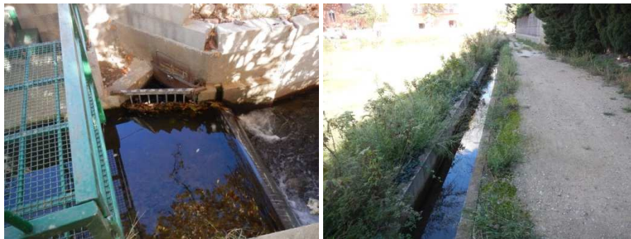
Fig. 9. Prise d'eau du Canal de Figarolle (à g.) et début de la partie aérienne du canal (à d.)
