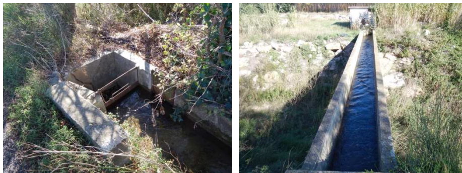
Fig. 13. Système de fermeture avant franchissement du Clot d'en Godail (à g.) et franchissement du Clot d'en Godail par le canal de Couloumine (à d.)
