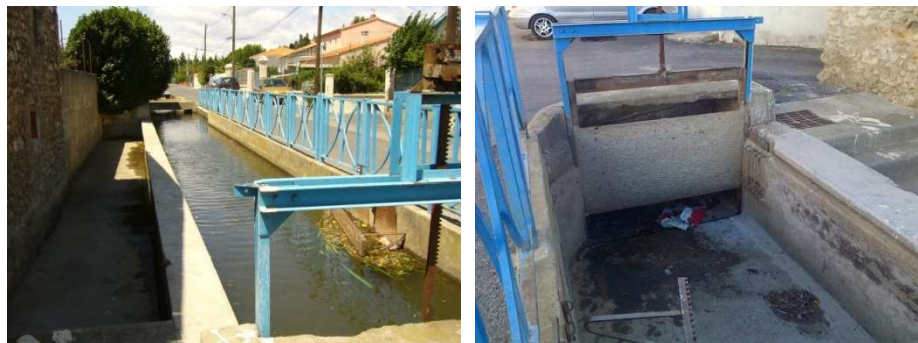
Fig. 5. Canal de Corneilla - entrée de l'ouvrage enterré
