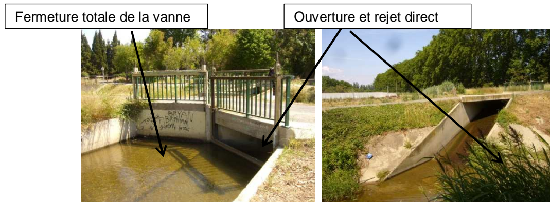
Fig. 4. Confluence Canal de Corneilla / Clot d'en Godail Vue amont de l'ouvrage (à g.) et vue aval du rejet direct dans le Clot d'en Godail (à d.)
