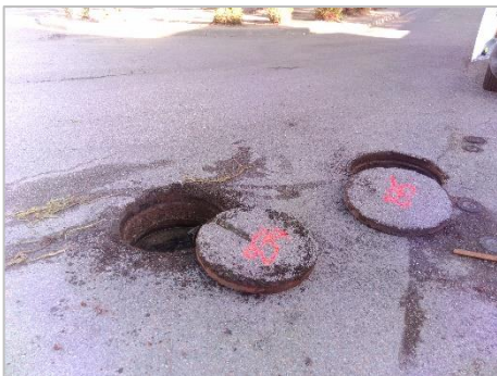
Chasse n°274 (Lotissement La Clave Verte) : présence d'un écoulement (débit de fuite \approx 0,1 \text{ m}^3/\text{h} )
