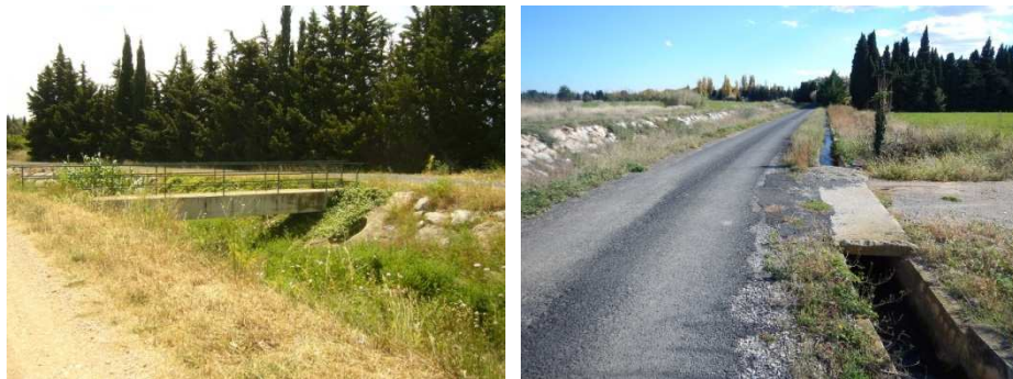
Fig. 11. A gauche : sortie directe du canal de Figarolle ou franchissement du canal de Figarolle vers la rive gauche du Campeils / A droite : canal de Figarolle en rive droite du Campeils
