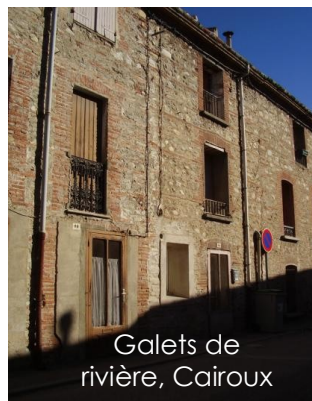
Enduit traditionnel (chaux, badigeon coloré dans les tons ocre jaune et rouge), poullie
